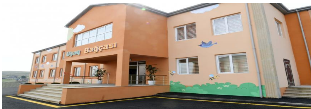
Рисунок 1. Новопостроенный ясли-детский сад №4 в поселке Шахрияр Шамахинского района (2019 г.)
