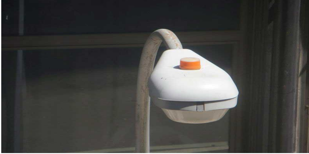
Şəkil 2. Qaz boşaltma lampasında işıq sensoru
